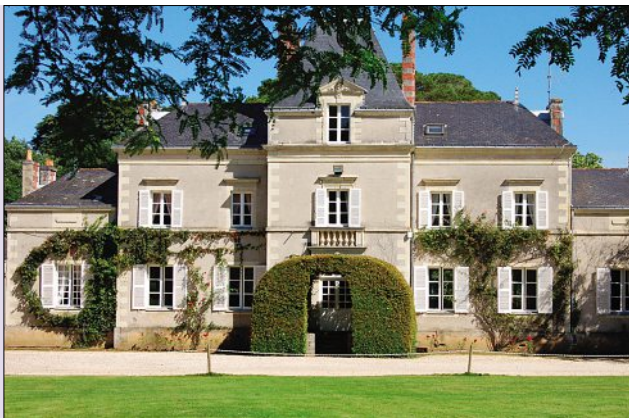
Façade de la propriété côté sud.
